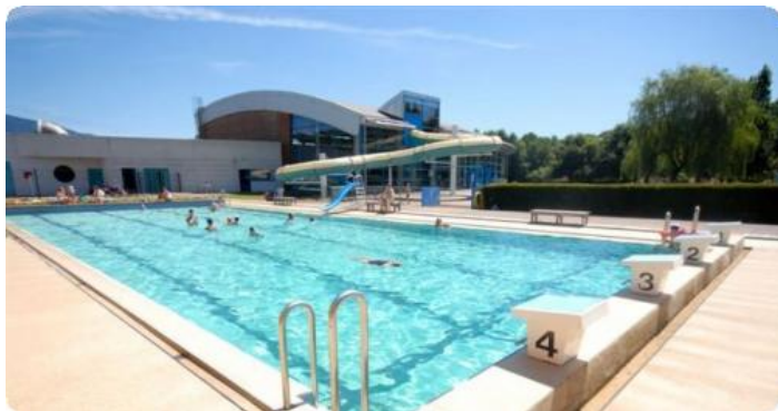
Vue du bassin extérieur alimenté par les panneaux solaires hybrides
