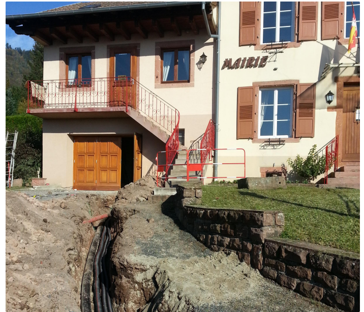
Pose du réseau de chaleur
