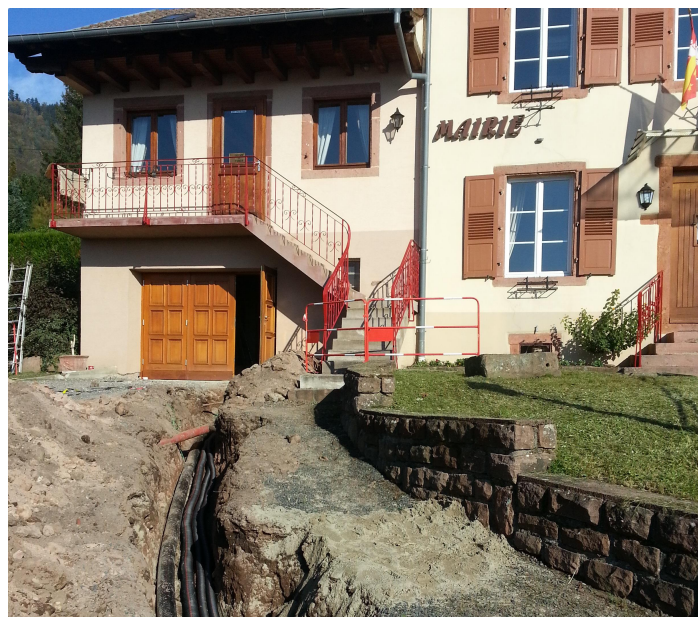
Pose du réseau de chaleur
