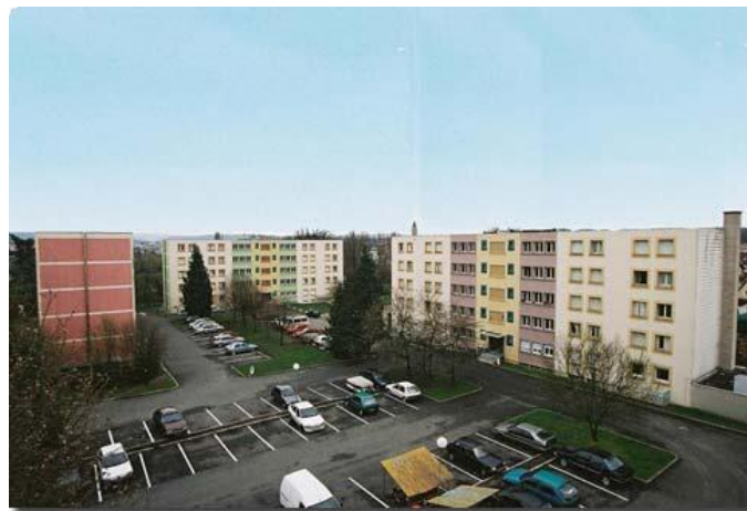
Vue d'ensemble de la résidence sociale d'Audincourt avant rénovation
