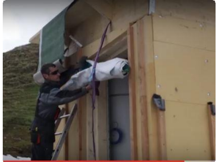
Construction du Local technique par Gest'hydrogène et Gest'performance
