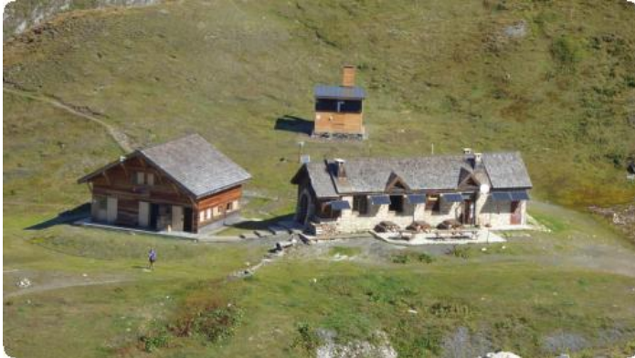
Le refuge du col du Palet dans le parc national de la Vanoise avec le local technique en arrière plan.
