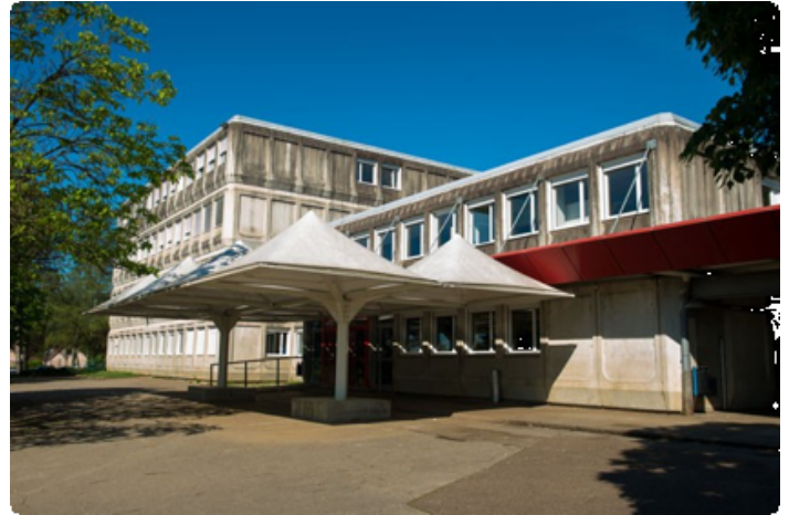
Collège de Quingey - Avant travaux - Maître d'ouvrage : CG du Doubs
