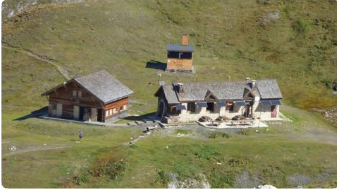
Installation refuge du col du Palet
