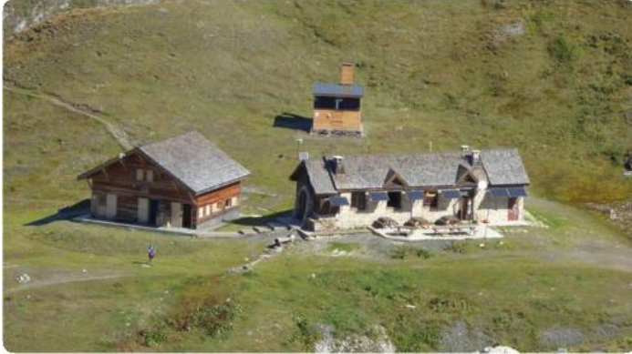
Installation refuge du col du Palet
