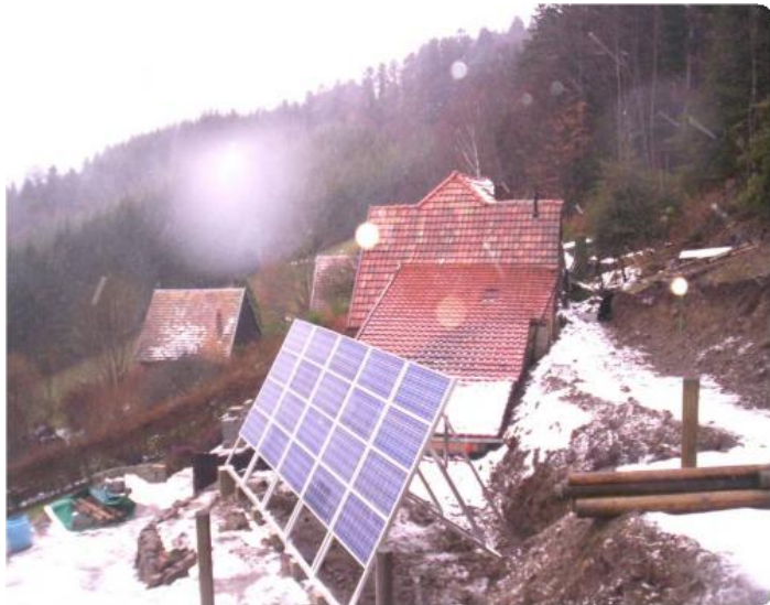
Installation à LINTHAL (68)
