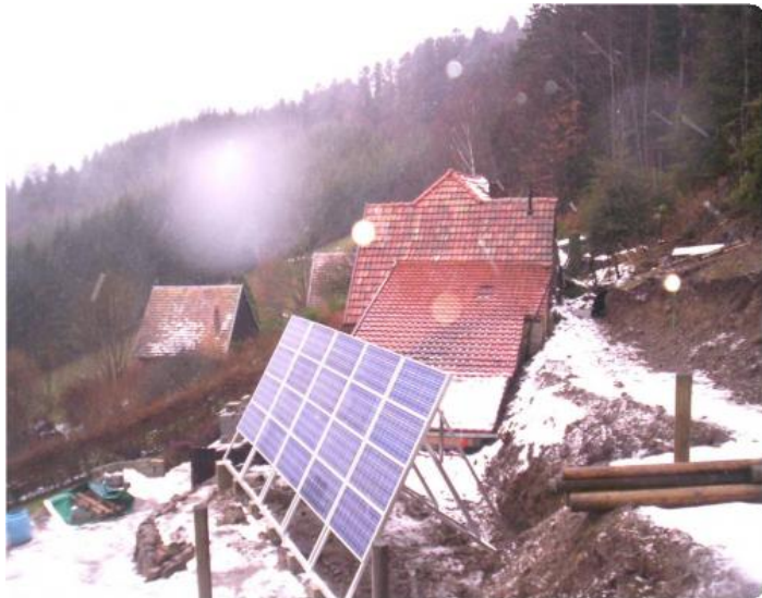
Installation à LINTHAL (68)
