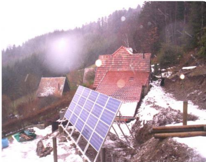
Installation à LINTHAL (68)
