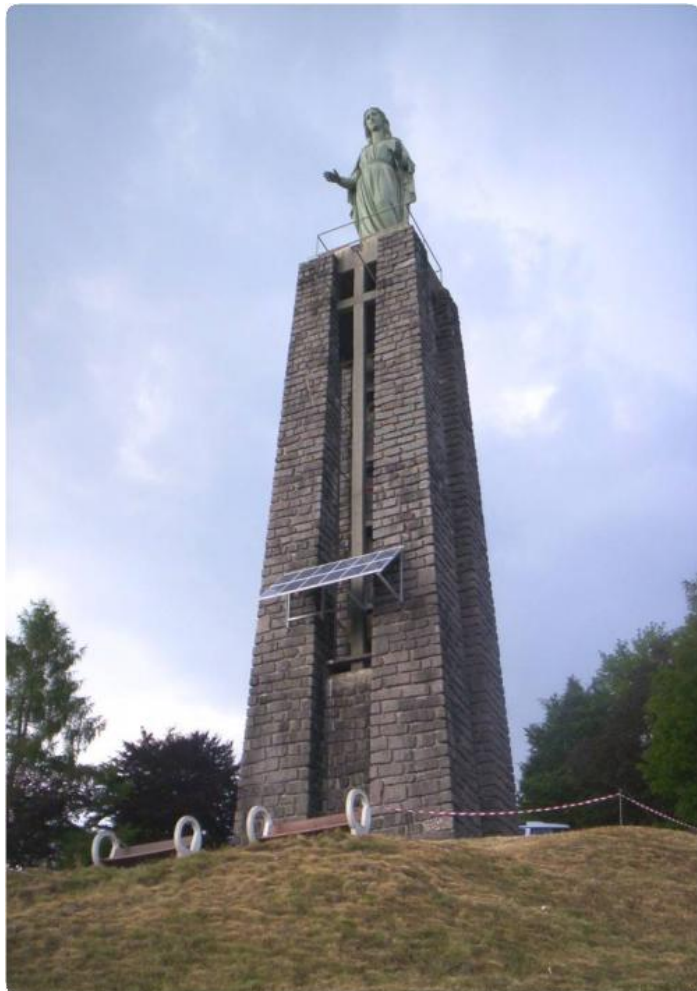
Installation à CORNIMONT (88)
