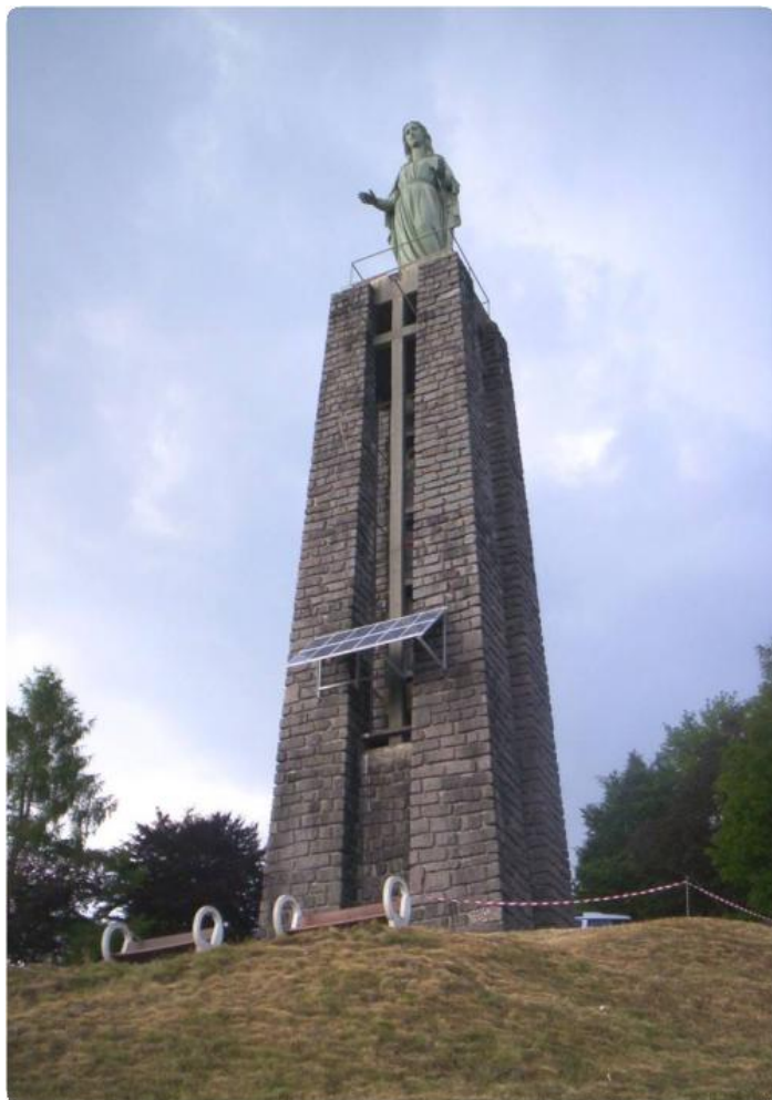
Installation à CORNIMONT (88)
