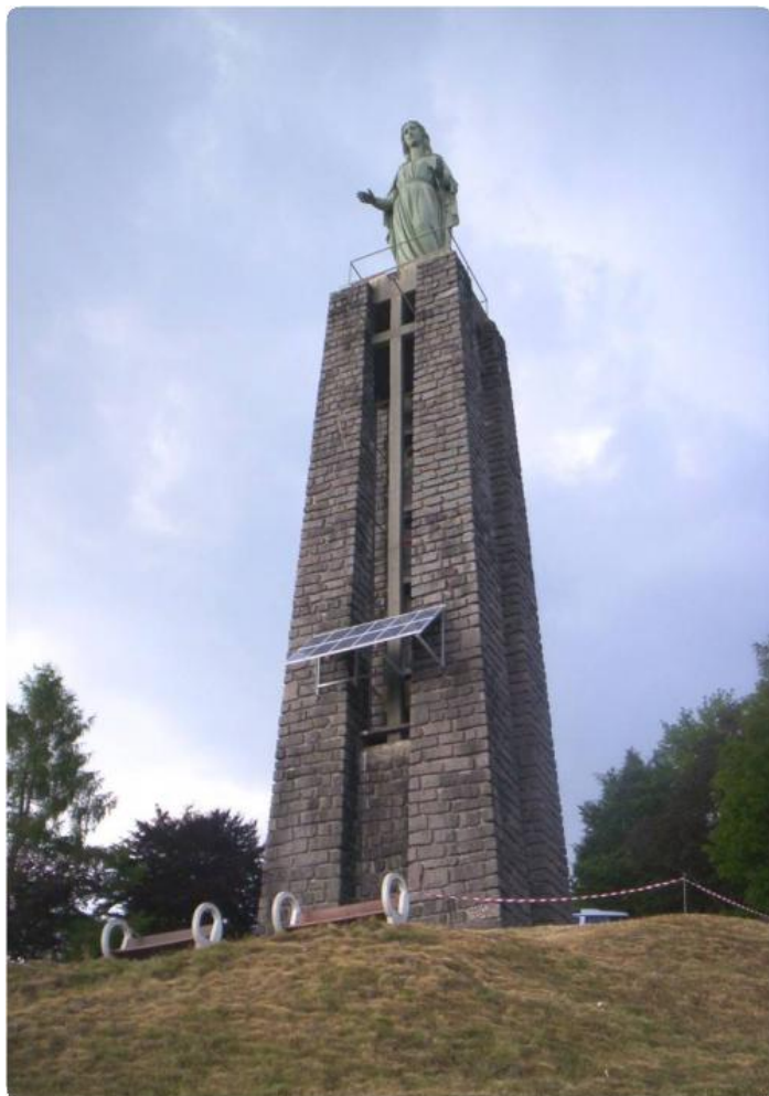
Installation à CORNIMONT (88)
