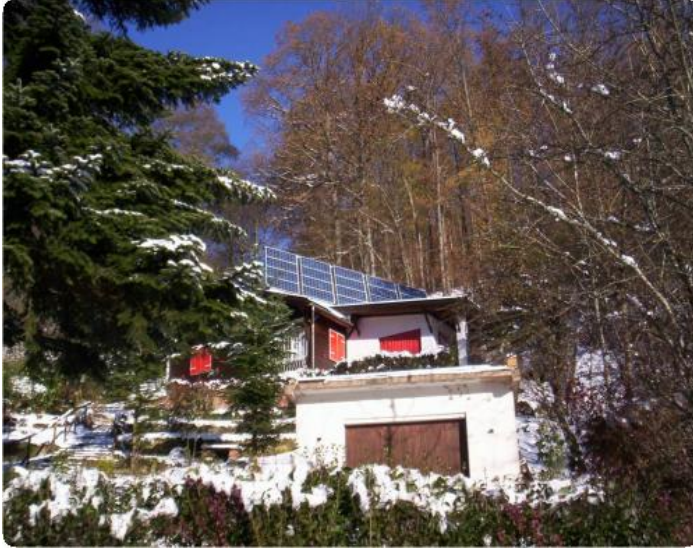
Site isolé à ANDLAU (67)
