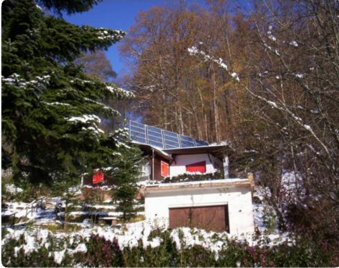
Site isolé à ANDLAU (67)
