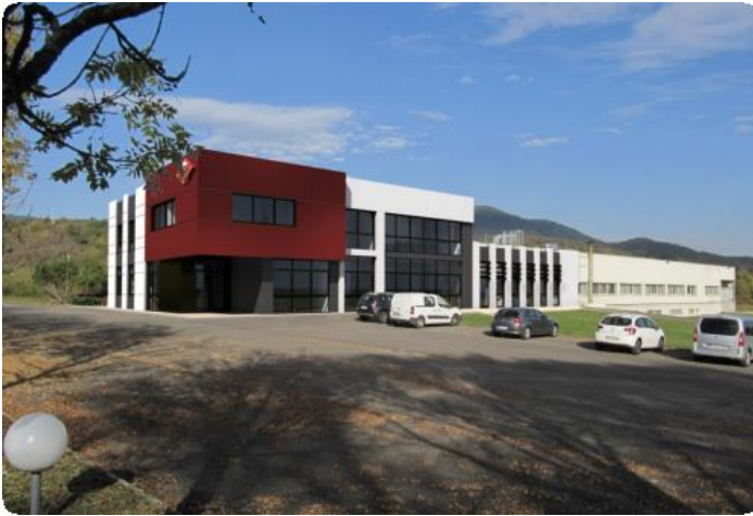
L'extension du pôle administratif de l'entreprise EGELHOF
